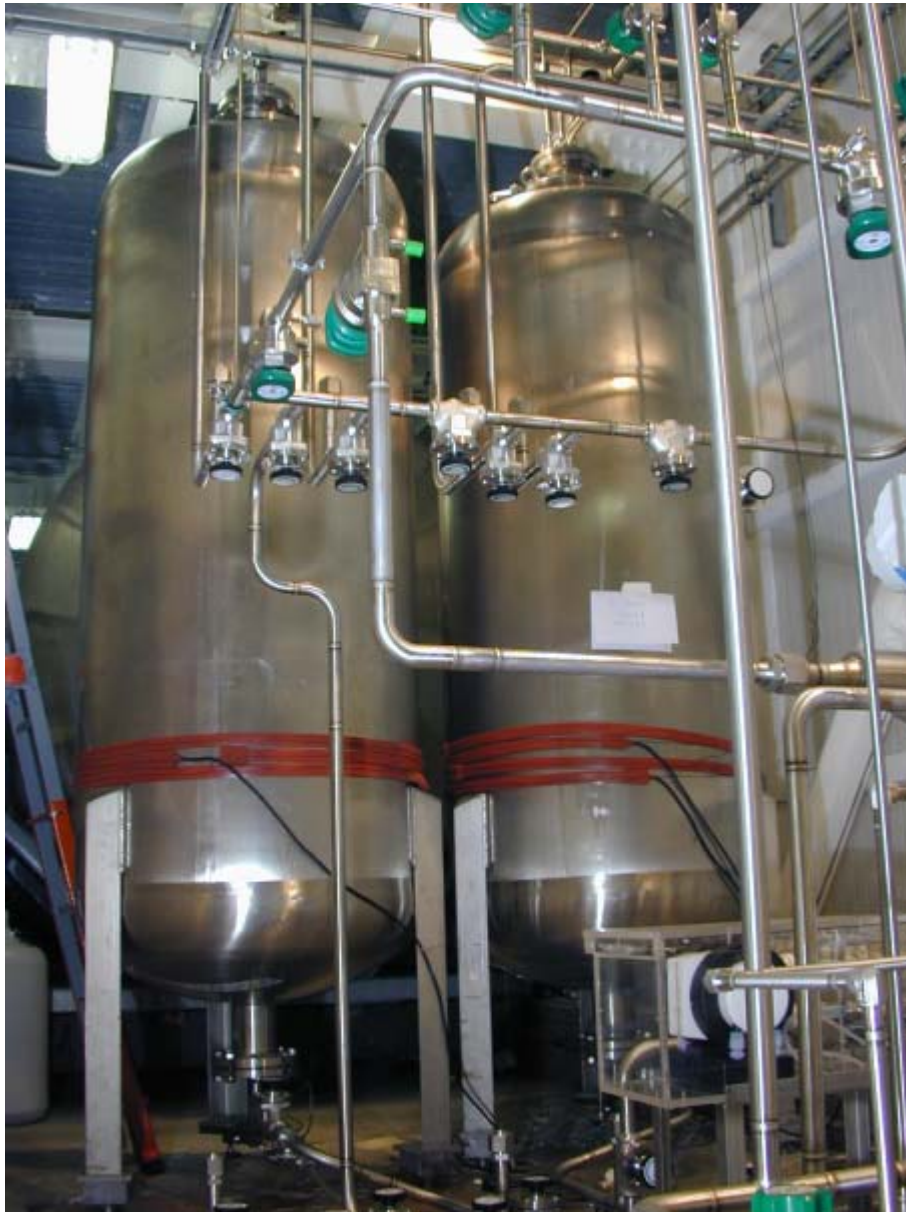
Abb. 3.1: Die beiden Buffer-Tanks des "Modul zero", die zum Zeitpunkt der Aufnahme gerade mit (roten) Heizbändern bestückt waren. Im Vordergrund oben das rechteckförmige "obere Manifold" sowie unten eine Pumpe. Links im Hintergrund deutet sich der runde Umriss eines EP-Tanks an.
