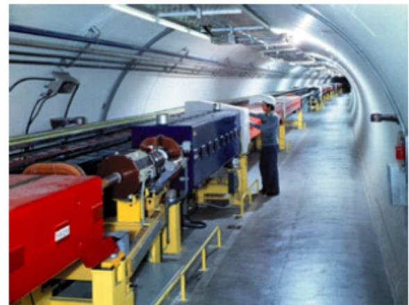
SPS Tunnel (oben); 1317 Elektromagnete, darunter 744 Diplomagnete
